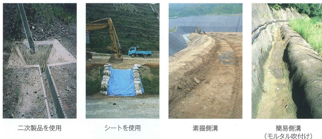
図 3.6 雨水排水溝の事例
