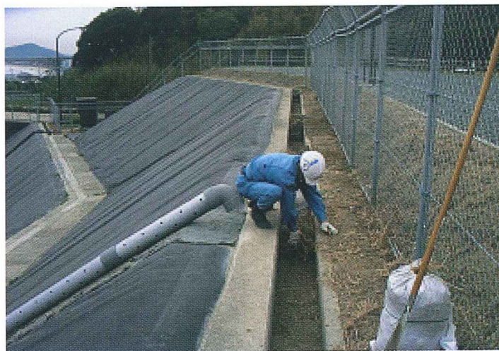
図 3.8 雨水集排水溝の点検清掃
