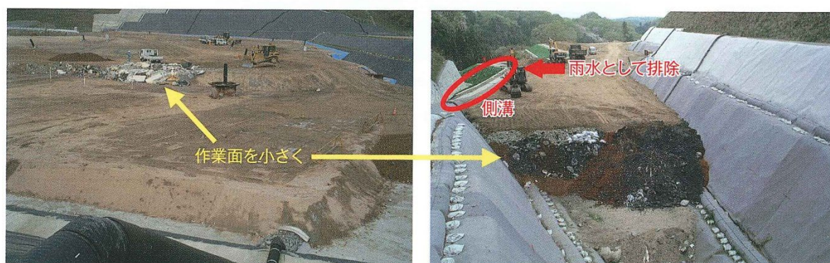
図 3.3 雨水排除の対策事例（覆土による）
