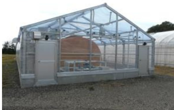
余剰熱供給施設建屋
