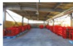
⑤ カードル充填場
