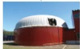
既存メタン発酵施設
