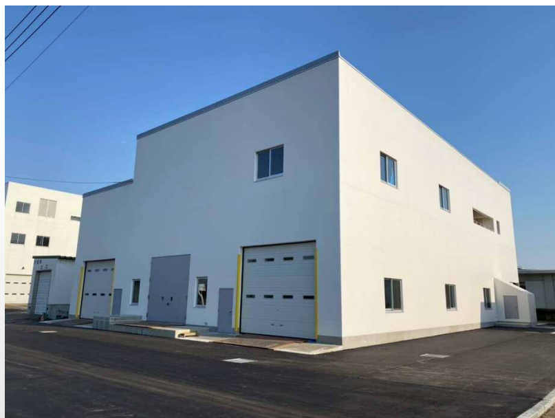
汚泥乾燥施設
