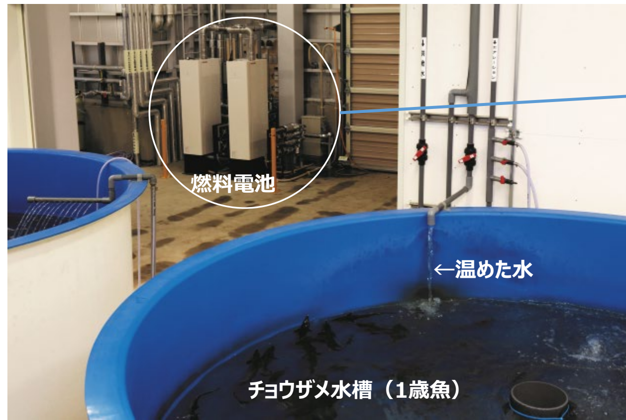
■ 燃料電池 700W出力×2基 (AC200V/100V単相3線)
