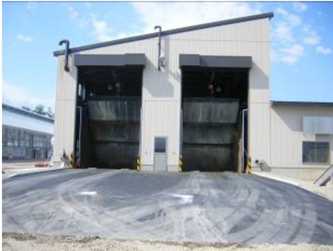
管理室・原料槽
