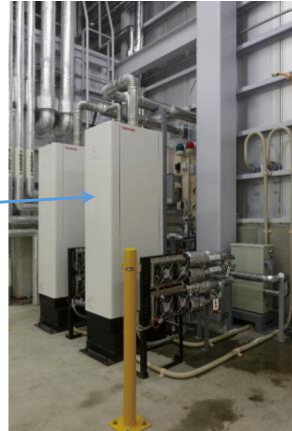
■ 燃料電池 700W出力×2基 (AC200V/100V単相3線)
