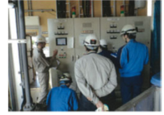
更新後の負荷運転調整
