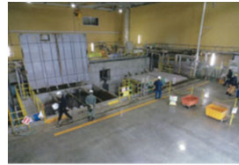
更新後の負荷運転調整
