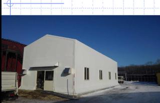
・こちらは新設のガスバック室となります。これまでの発酵槽上部のガスドーム廃止により別途ガスホルダーが必要となったため、ガスバック収納用として設置しております。
